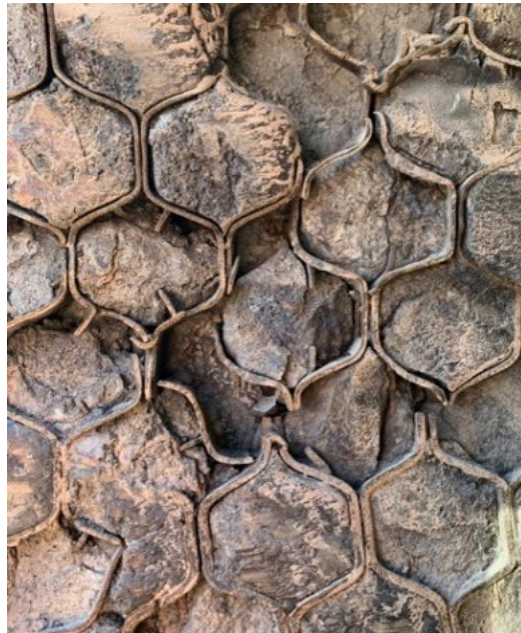
閉鎖式セルシステムの設計上、ライニングの背後に到達する経路が許容されています。
