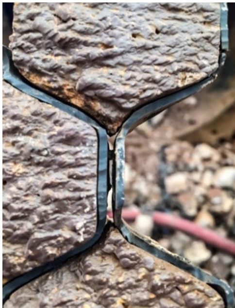
閉鎖式セルシステムの設計上、ライニングの背後に到達する経路が許容されています。
