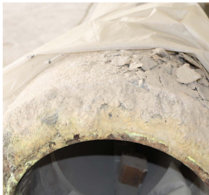
Fig 7 : このように SpeedCell® は運転時に全ての振動を吸収し耐火材全体を保持することが出来ます。
